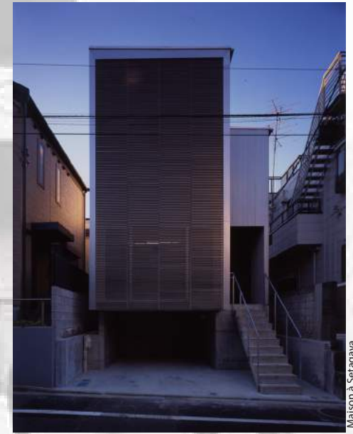
Maison à Setagaya
